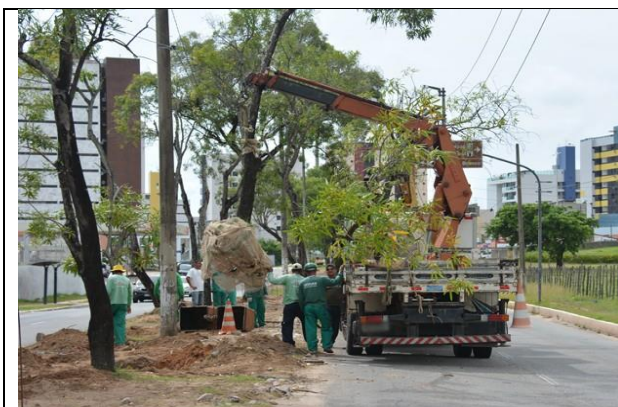
Foto 1. Retirada de 32 árvores do canteiro central da Av. Beira Rio. A ação faz parte das obras de alargamento da avenida Beira-Rio. Fonte: DIVAR/DCA/SEMAM/PMJP, 2015
